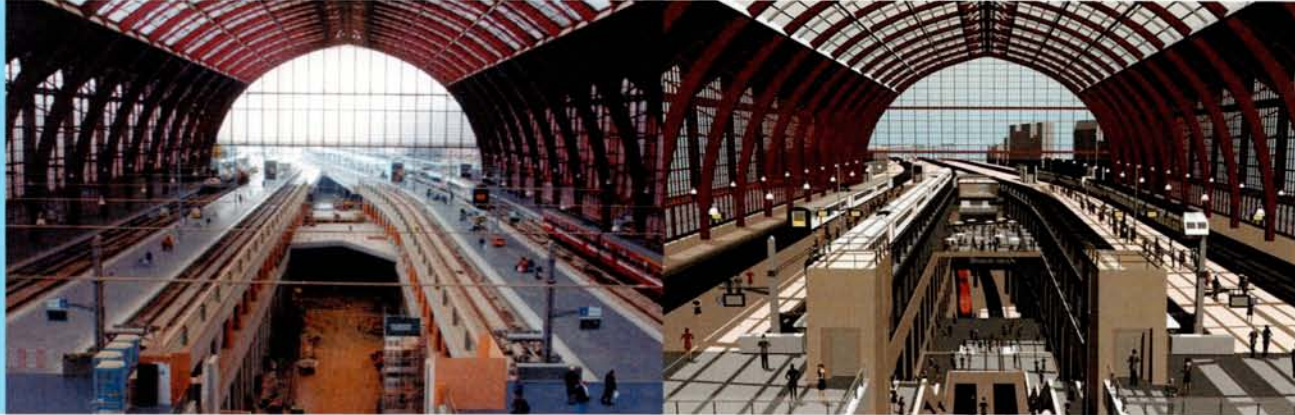
Sinds eind 2003 is het vernieuwde +1 niveau klaar.
