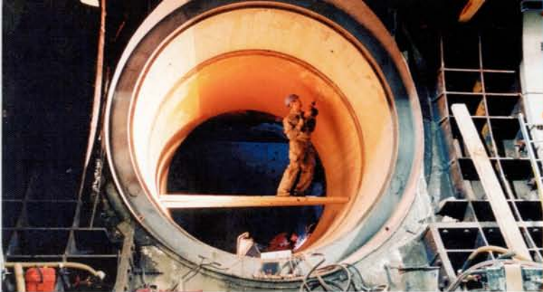
In de spoortunnel bevinden zich twee dwarsverbindingen.
